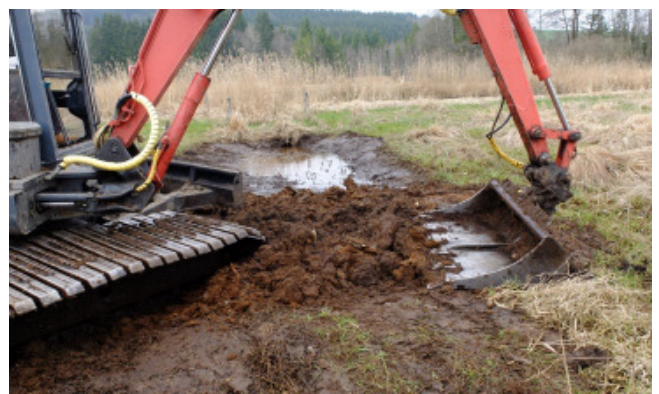
Grabenaufweitung (hinten), fertiger Pfropfen aus unzersetztem Torf
