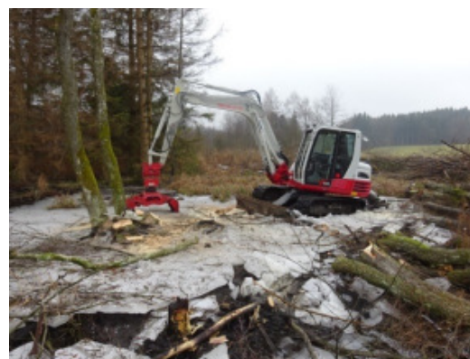
Raupengreifer, Umsetzung in schwierigem Gelände
