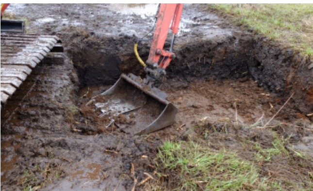
Baugrube zum Einbau eines Torfpfropfens
