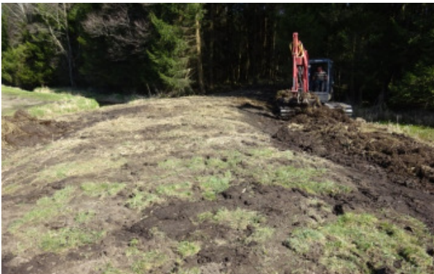
Bau des Dammes (links Gründlen Ach, rechts Randlagg)
